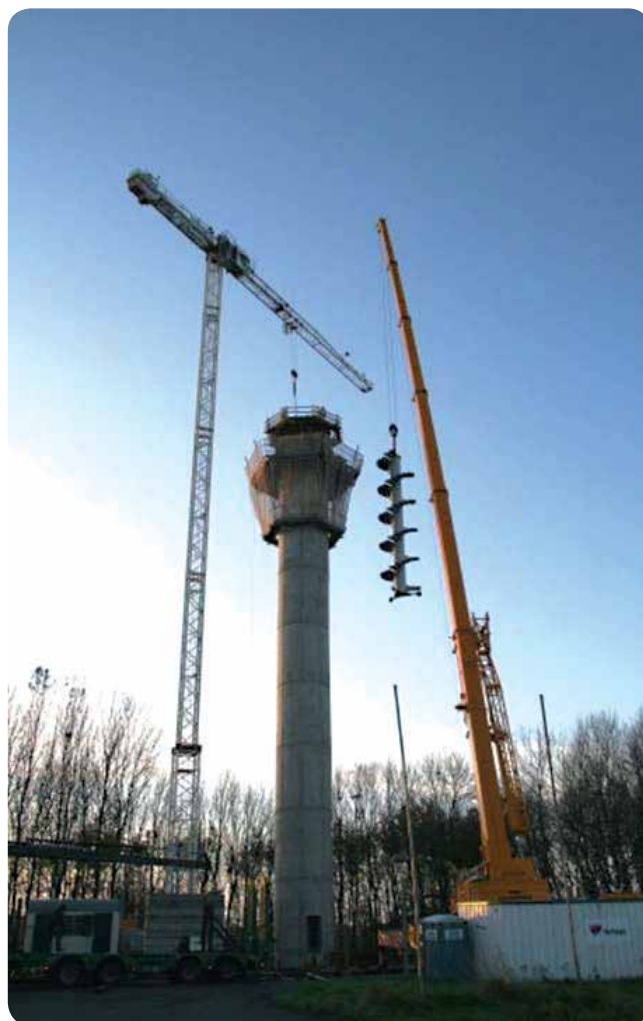
Figure 4.1 : construction de la tour radar de Jabbeke : Installation de l'escalier en colimaçon le 19 décembre 2008.
