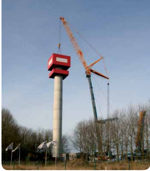
Abbeelding.1.4 : Foto van de bouw van de radartoren te Jabbeke
